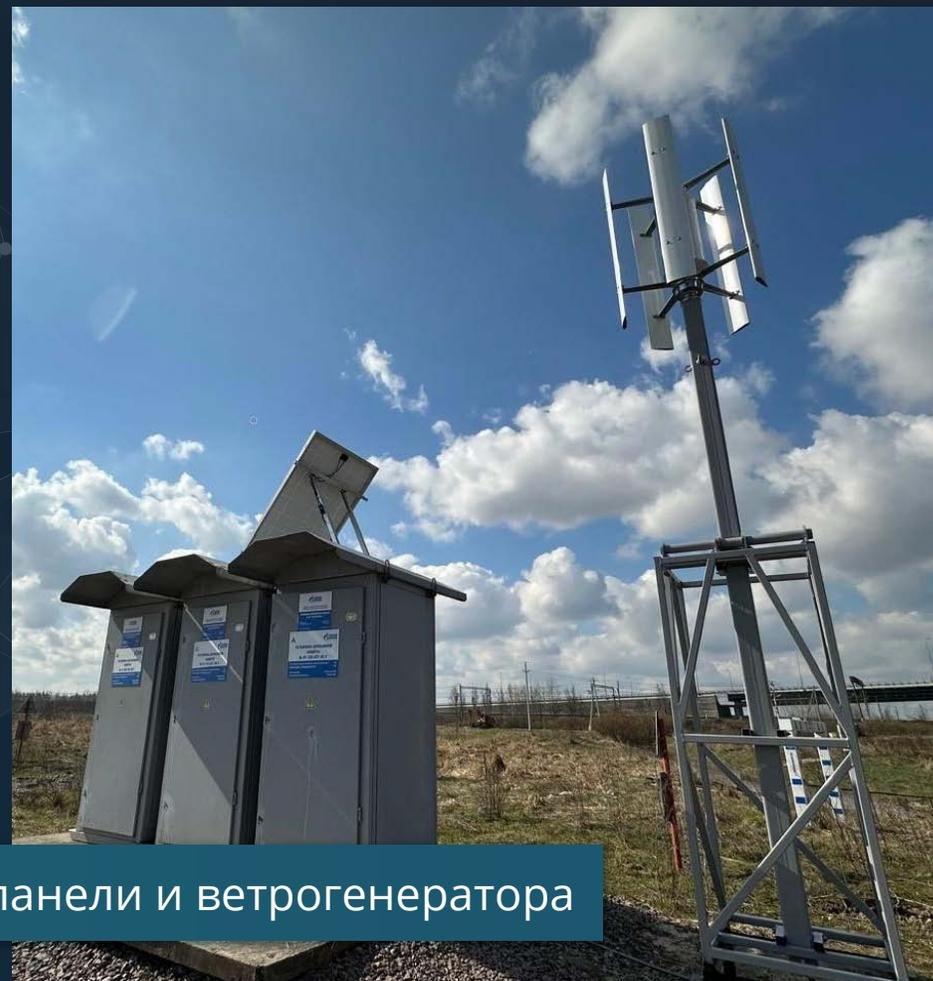
Система автономного электропитания ЭНТЕЛ на базе солнечной панели и ветрогенератора
